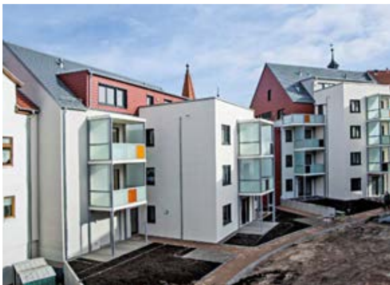
Im Herzen der Stadt Gotha schuf die wbg modernen, weitgehend barrierefreien Wohnraum. Im Rahmen der umfassenden Erneuerung des umliegenden wbg-Bestands entstand auch ein gemeinsamer Wohnhof
