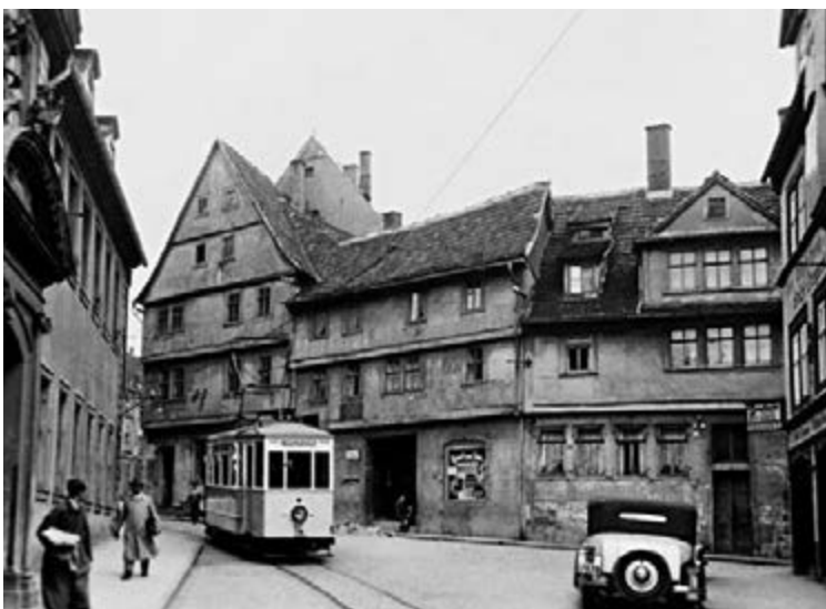
Die historischen Gebäude – darunter das älteste Fachwerkhaus Gothas – mussten leider abgerissen werden. Eine Folge von Bauschäden aufgrund langjährigen Leerstands
